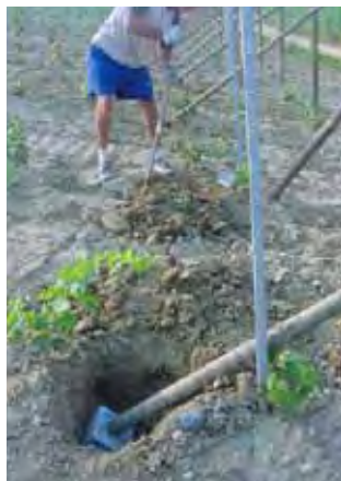
(A) - Avvitamento delle ancore tramite apposita attrezzatura a barella (Ferro A.).
