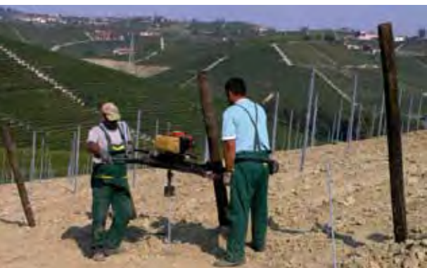
(A) - Avvitamento delle ancore tramite apposita attrezzatura a barella (Ferro A.).
