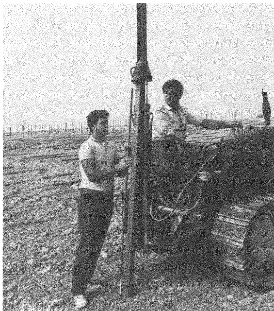
Fig. 23 - Impianto dei pali. (FETTO)
