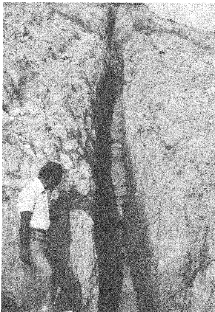
Fig. 5 - Drenaggi a grande profondità.
