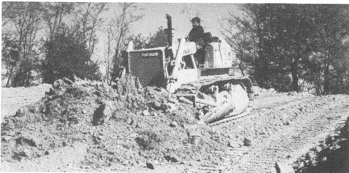
Fig. 4 - Sbancamento con cingolato.
