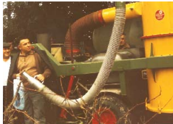
Vendemmiatrice per aspirazione di costruzione tedesca (Moco-Scharf)
