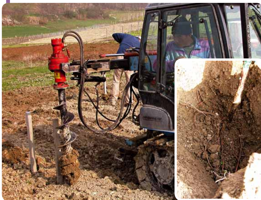
Foto 1 - Buca scavata con trivella
