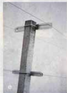
e) Mensole in acciaio inossidabile. f) Particolare di "cravatte" per collegare il puntone al palo di testata di diversa forma.
