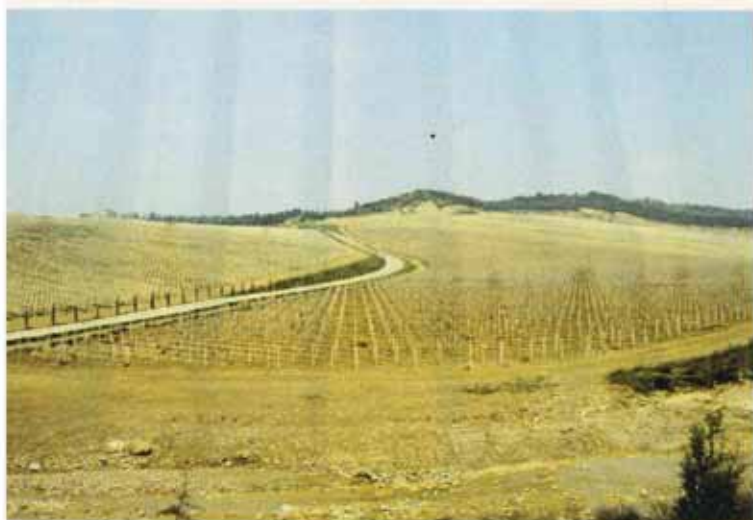
Foto 6 - Impianto realizzato in Toscana nel 1988 con pali di cemento precompresso (foto A. Morando).
