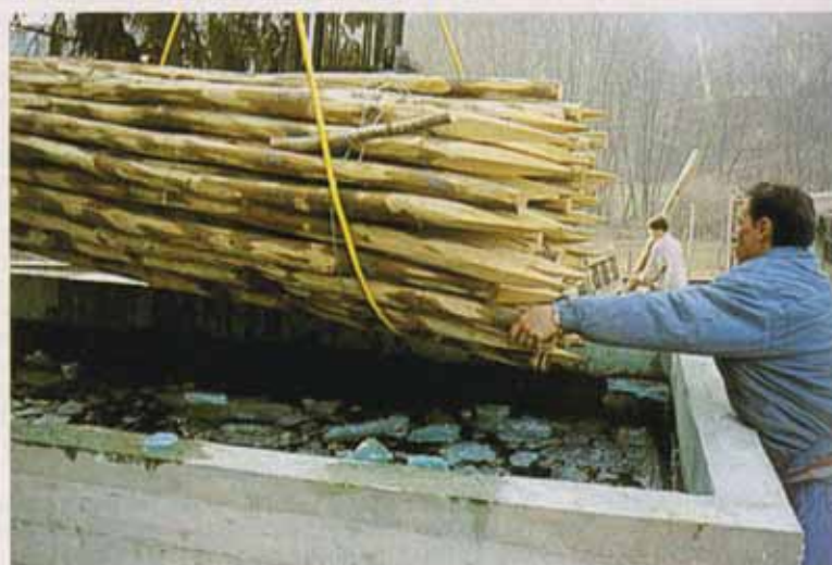
Foto 4 - La successiva immersione dei pali in una soluzione di solfato di rame aumenta ulteriormente la durata del sostegno (foto A. Morando).
