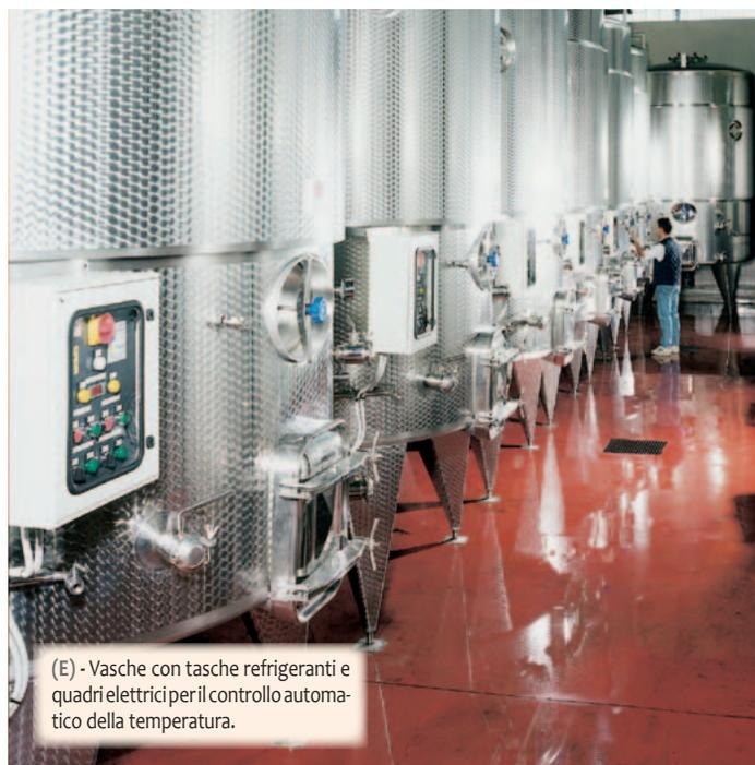
(E) - Vasche con tasche refrigeranti e quadri elettrici per il controllo automatico della temperatura.
