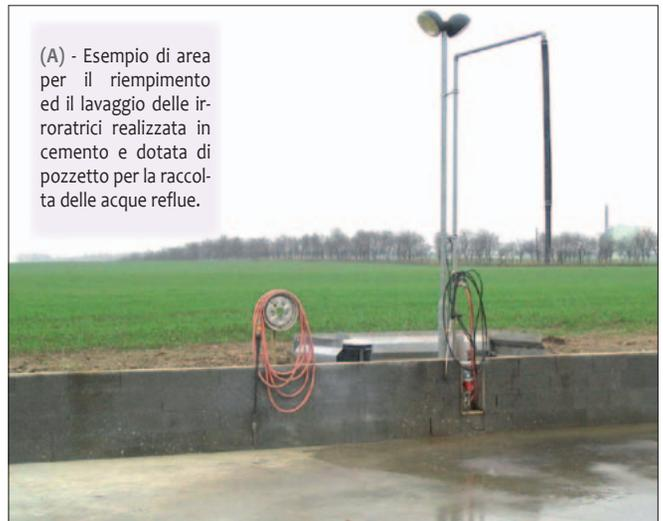
(A) - Esempio di area per il riempimento ed il lavaggio delle irroratrici realizzata in cemento e dotata di pozzetto per la raccolta delle acque reflue.
