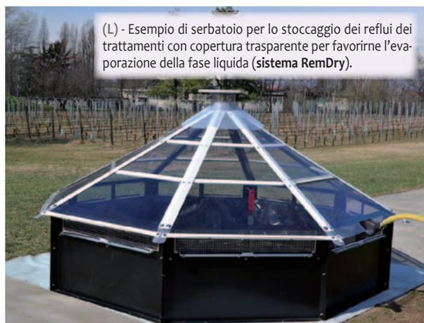
(L) - Esempio di serbatoio per lo stoccaggio dei reflui dei trattamenti con copertura trasparente per favorirne l'evaporazione della fase liquida (sistema RemDry).
