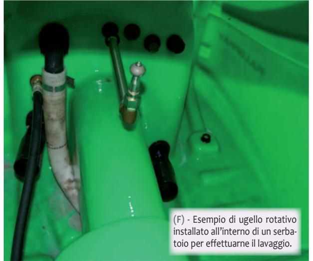
(F) - Esempio di ugello rotativo installato all'interno di un serbatoio per effettuarne il lavaggio.
