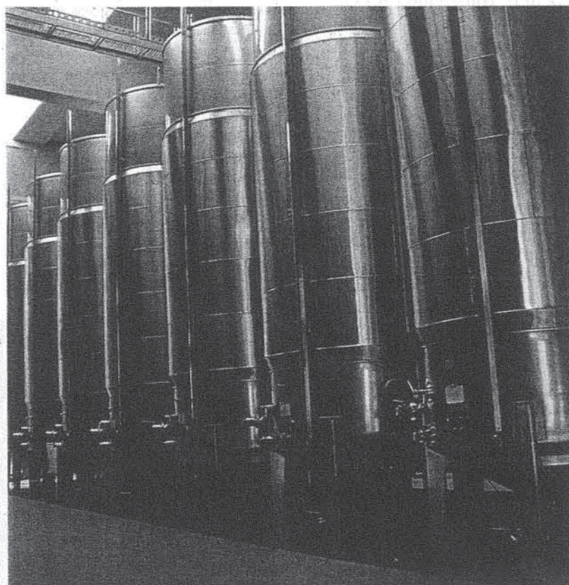
Figura 53: serbatoi termocondizionati per la defecazione a freddo e la fermentazione controllata (Villa Banfi). Figure 53: temperature-controlled tanks for cold defecation and controlled fermentation.
